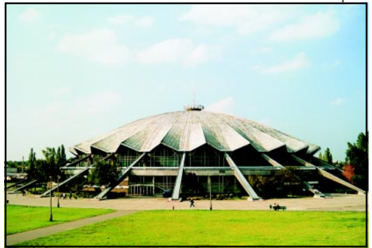
Poznań, hala „Arena”, fot. Z. Szmidt.
