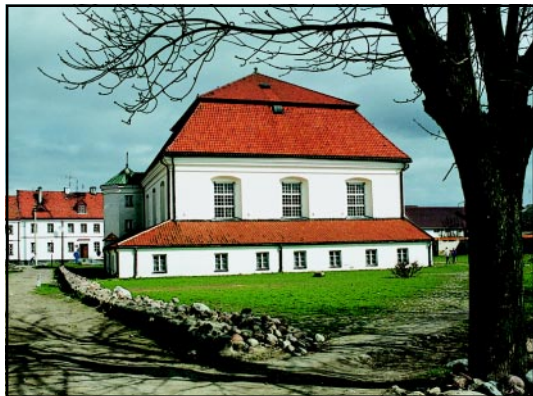
Tykocin, synagoga, fot. St. Kryciński.
